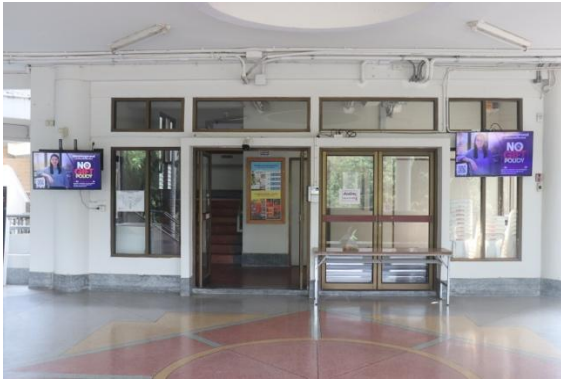
จุดที่ 1 หน้าโถงบันไดชั้น 1 อาคาร 1
